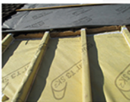
geschlaufte Luftdichtheitsschicht mit Sanierungsleisten
